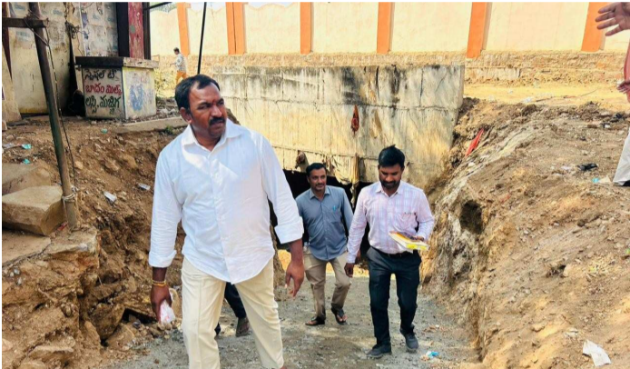
రాజంపేట(ప్రజా సీమ) : కడప జిల్లా రాజంపేటలోని 103 ఆర్ యు బి పనులను రాజంపేట ఎమ్మెల్యే ఆకేపాటి అమర్నాథ్ రెడ్డి
